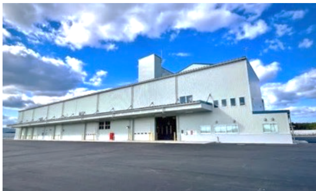
＜浪江町棚塩ラック式カンントリーエレベーター＞
